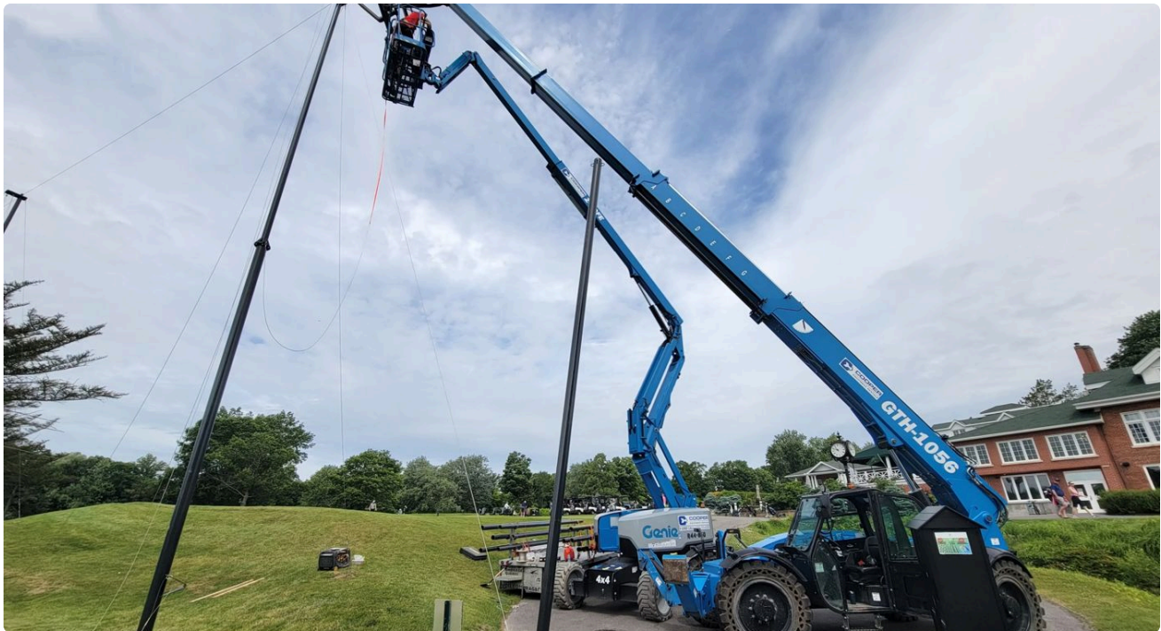
L'installation : l'équipe lève les poteaux avec une nacelle. Après, plus besoin.
